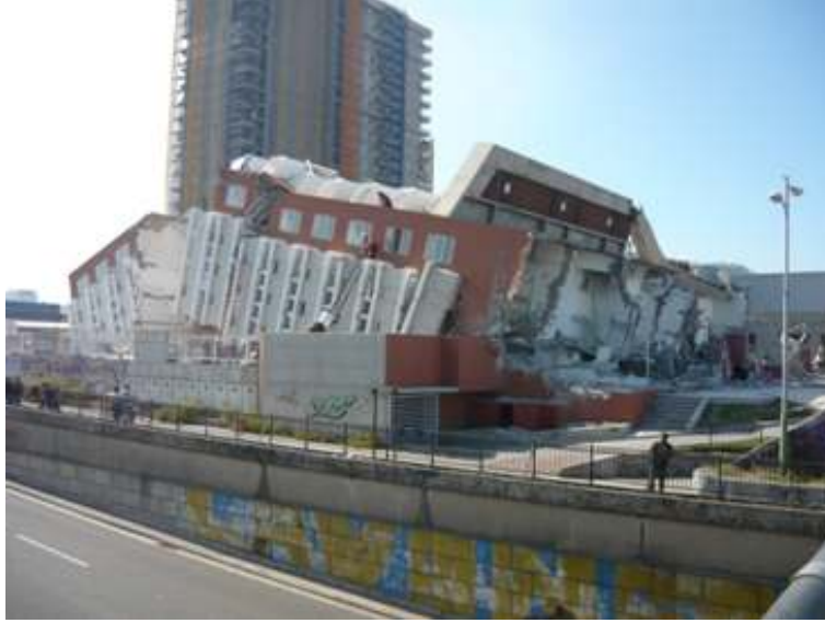
Figura 2.9: Edificio Alto Río luego del terremoto 8,8 [Mw] del 27 de febrero del año 2010, imagen personal.
