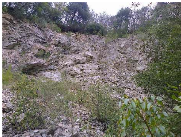
Figura 1.6: Afloramiento rocoso en un costado en la parte superior del túnel, imagen gentileza Arturo Belmonte
