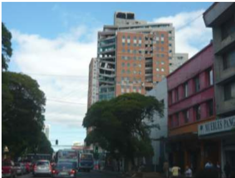
Figura 2.3: Torre O'Higgins emplazada en el Concepción Metropolitano luego del terremoto 8,8 Mw. del 27 de febrero del año 2010, imagen personal.
