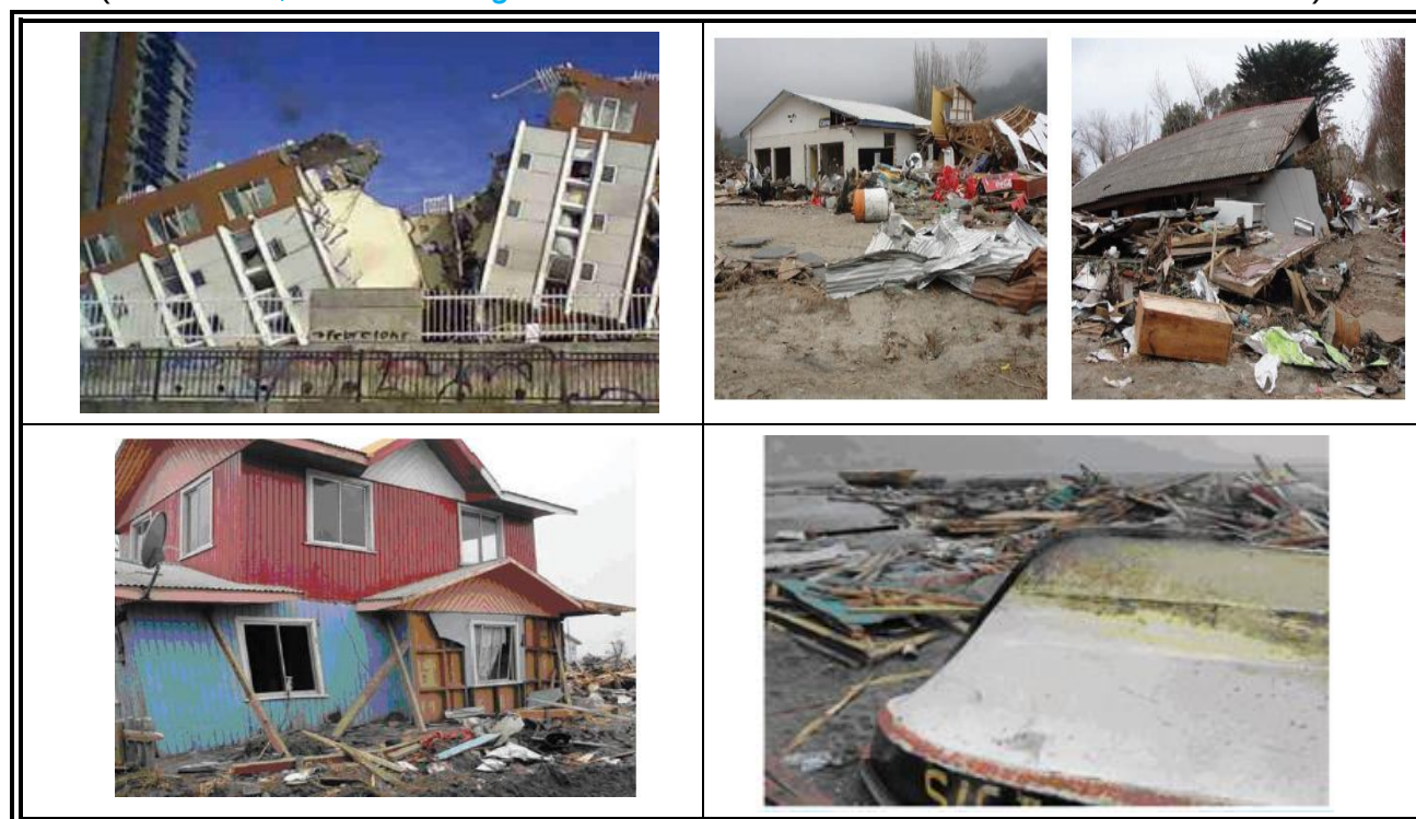
Figura 1.1.2- Imágenes del nivel de destrucción provocados por el terremoto y tsunami del 2010 en diferentes ciudades. ( Crédito: Muñoz R. Revista Urbano, octubre 2010. )
